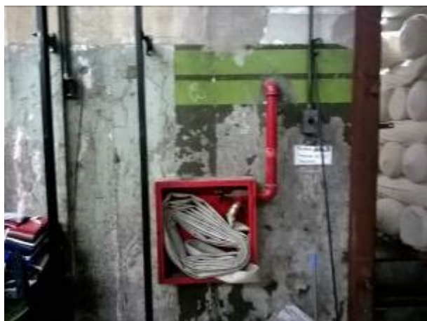
Sistema fijo de agua para incendios
