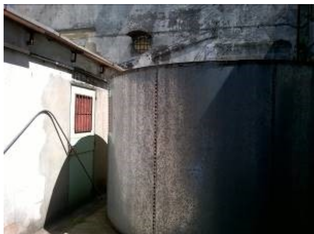
Sistema fijo de agua para incendios
